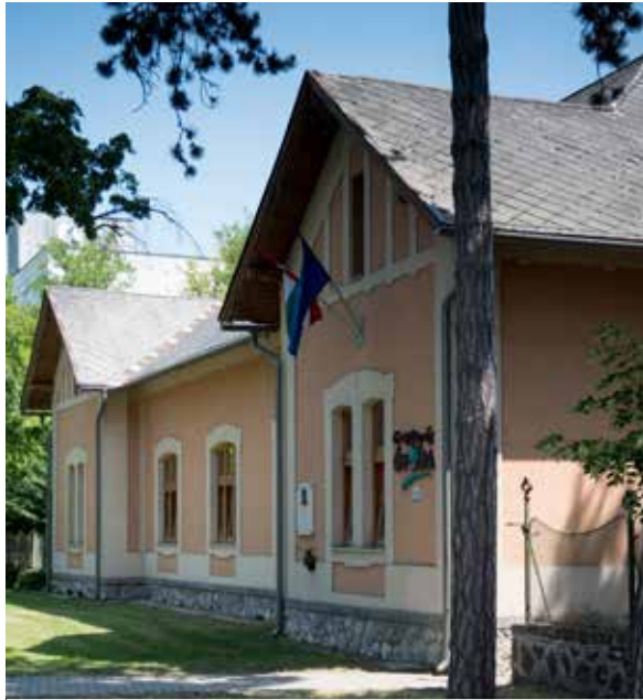
Gesztenyés Óvoda felújított épülete
