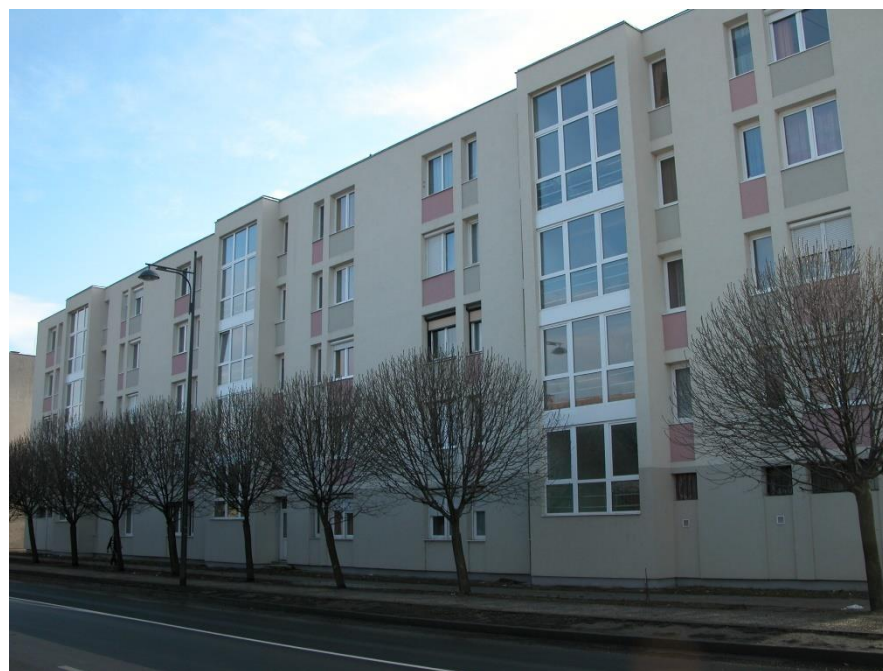
4. ábra: 1782/72 hrsz blokkos lakóépület energetikai felújítása és homlokzati színezése
